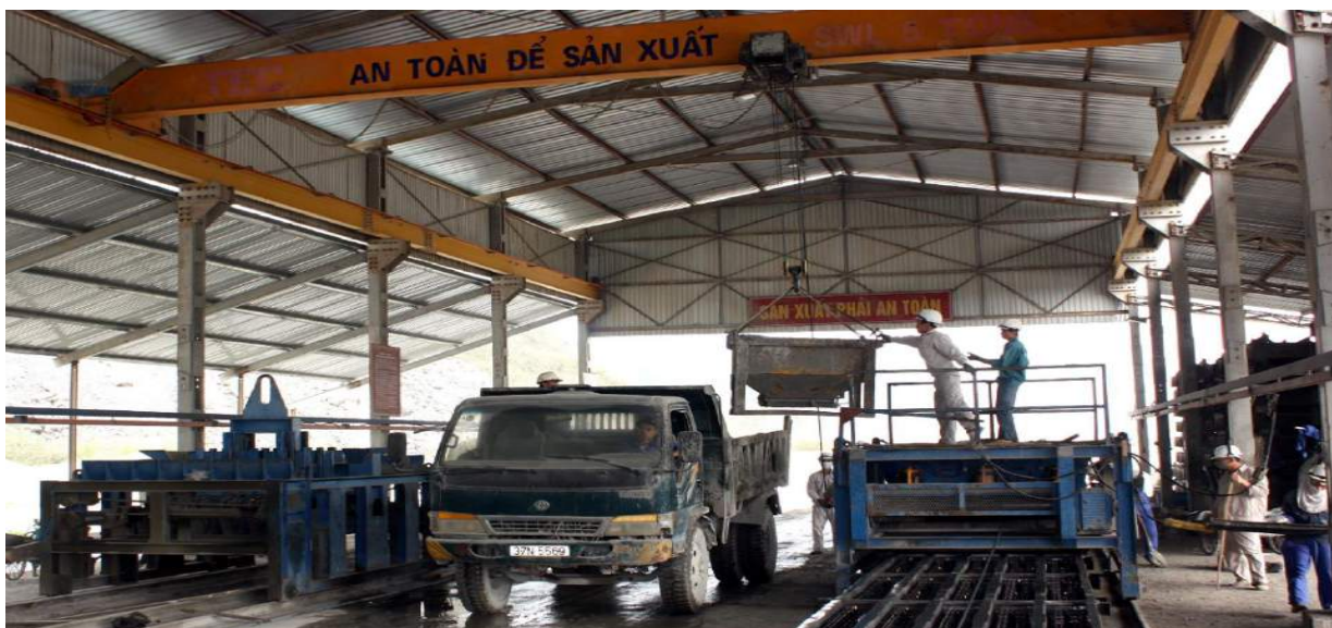
ĐÚC TÀ VỆT BÊ TÔNG DỰ ỨNG LỰC
