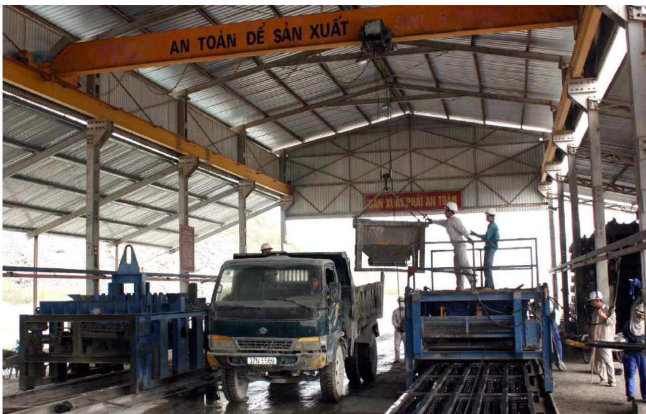
ĐÚC TÀ VỆT BÊ TÔNG DỰ ỨNG LỰC
